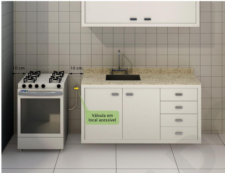
Figuras 11-B: Válvula de boqueio em fogão apoiado no piso – lado gabinete.
