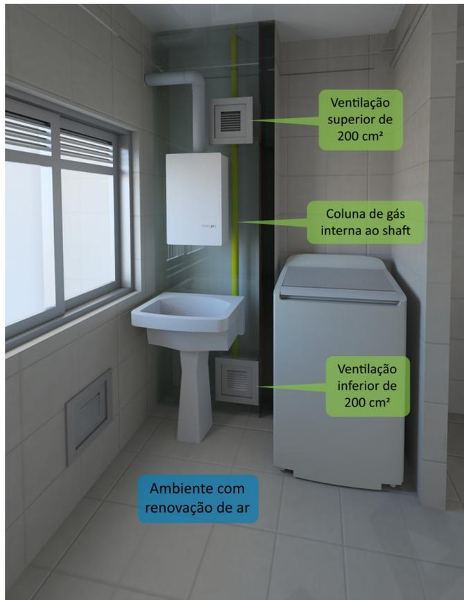
Figura 5-6: Instalação de gás interno ao shaft.
